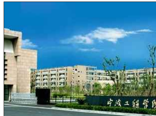
▲ 宁波工程学院宿舍楼
